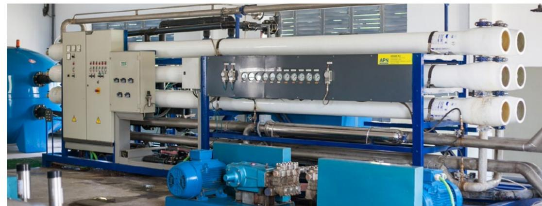
Figura 4: Sistema de dessalinização da Central.
