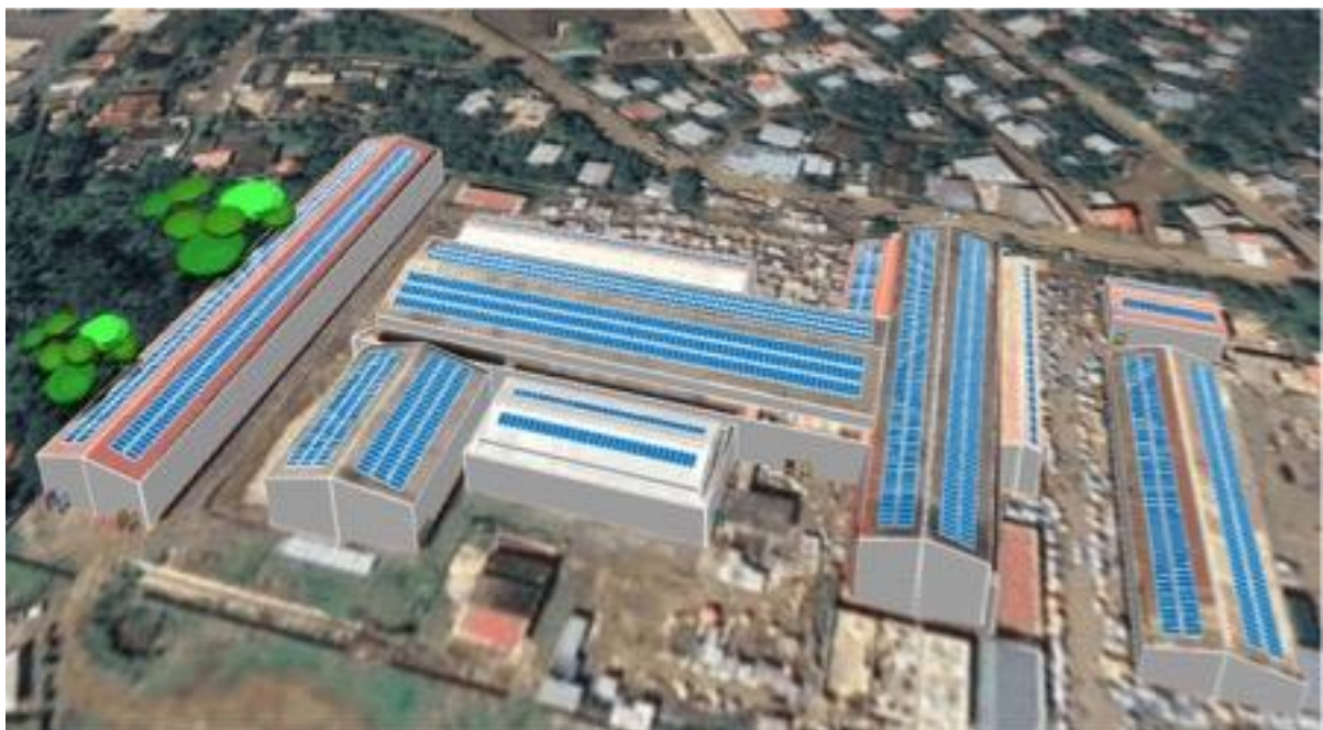
Figura 127: Local n.º 15 (Mercado de Bobo Foro) com uma capacidade fotovoltaica estimada de 937 kW p
