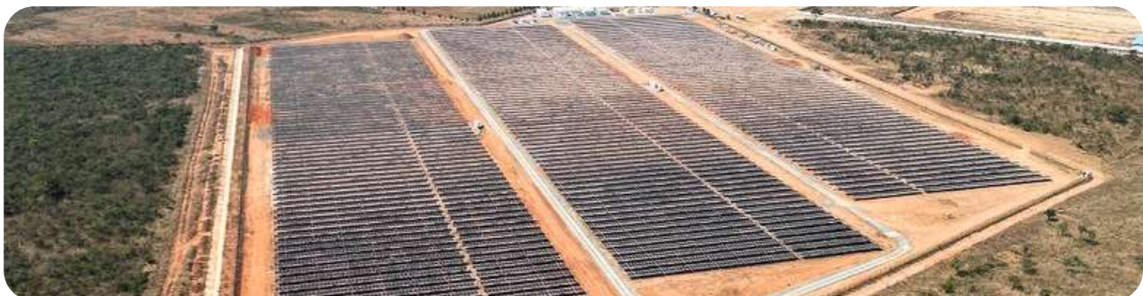
Projecto solar de 370 MW da MCA em Angola.
